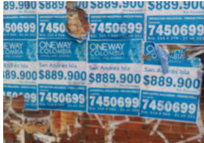
Fotografías 1, 2 y3. Fachada de la Carrera 7 No 147-02
